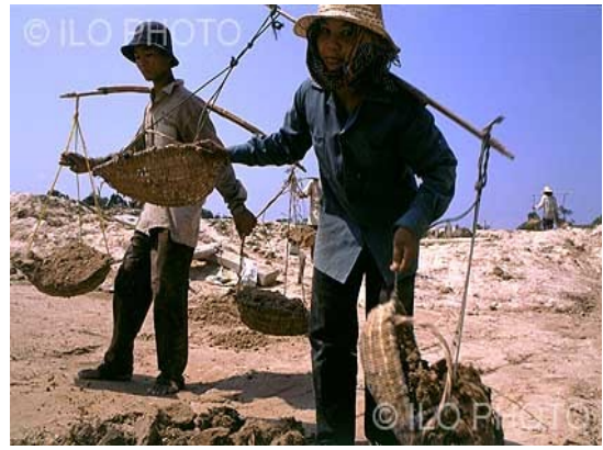
2. Construction d'une route au Cambodge
