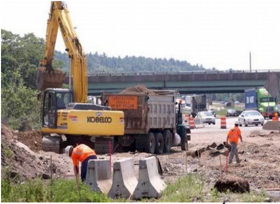
1. Construction d'une route aux États-Unis
